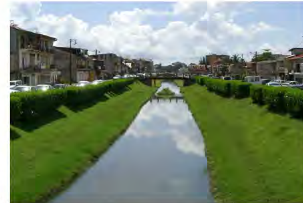
Aménagement paysager - Canal Laussat
