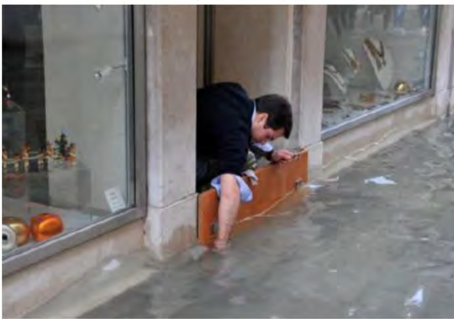
Pose de batardeaux
