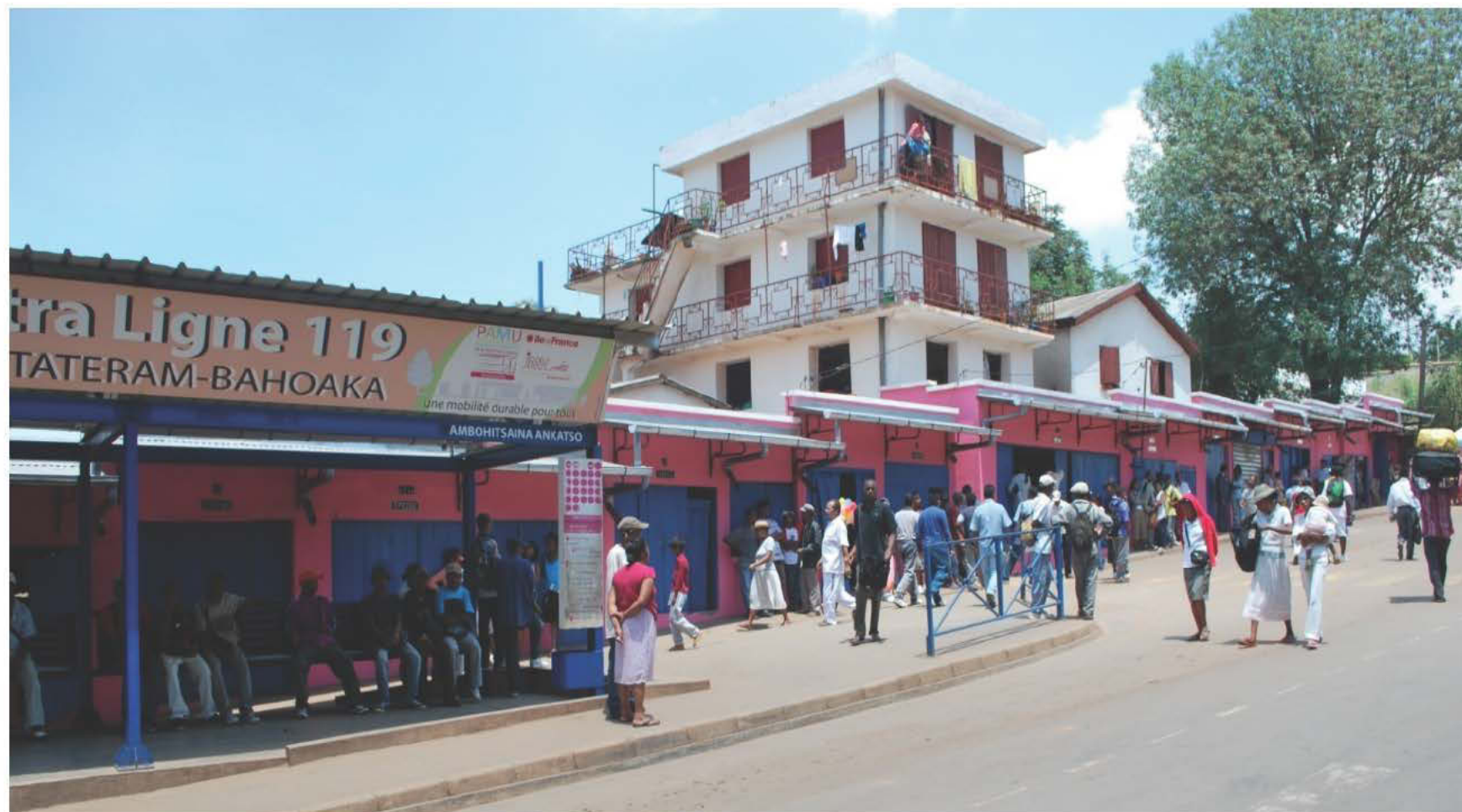
Abribus et travaux d'embellissement des gargotes à Ankatso (inauguré en décembre 2011)
