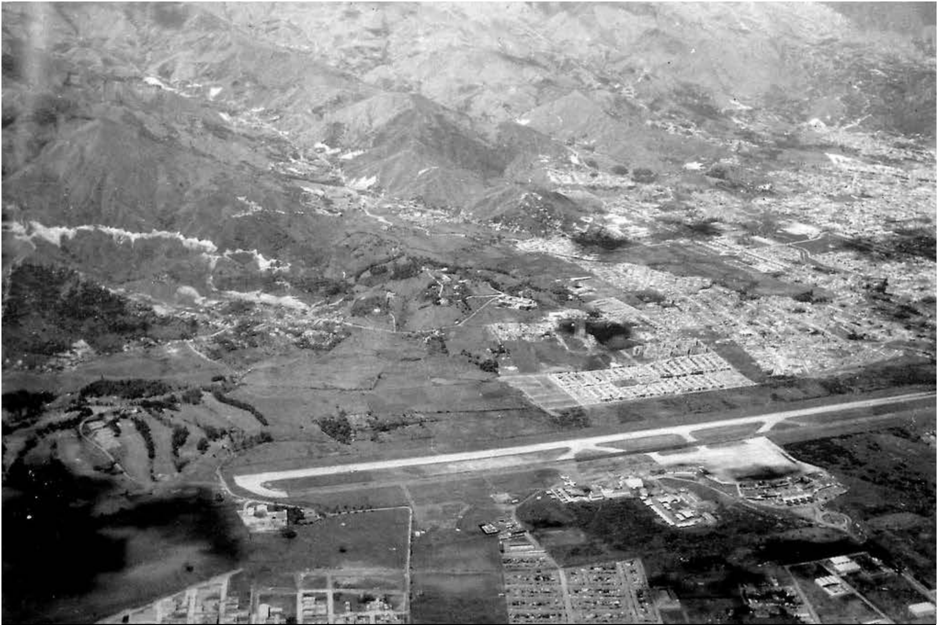
Construcción aeropuerto Enrique Olaya Herrera, año 1955
