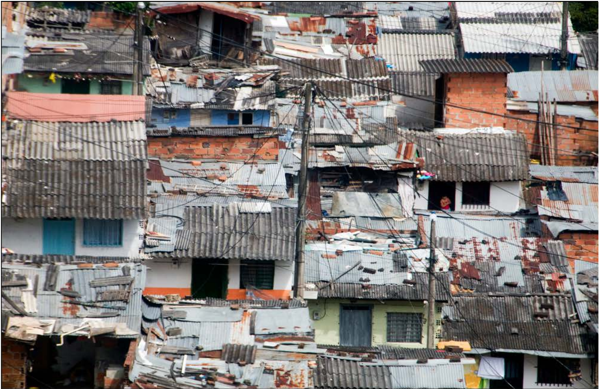
Redes de energía en los barrios de origen informal.
